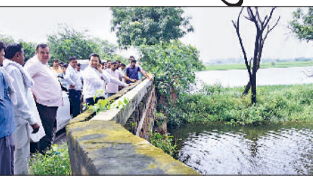
रोहतक। विभिन्न गांवों में जल निकासी के कार्यों का निरीक्षण करते उपायुक्त सचिन गुप्ता। फोटो: हरिभूमि
